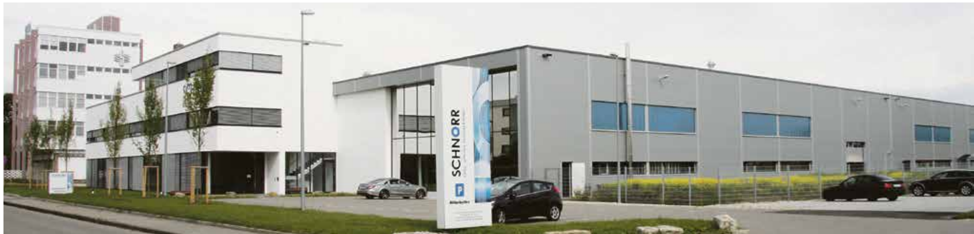
Zeitenwende bei der Firma Schnorr: Hier der Neubau, links im Hintergrund der Altbau der demnächst abgerissen wird
