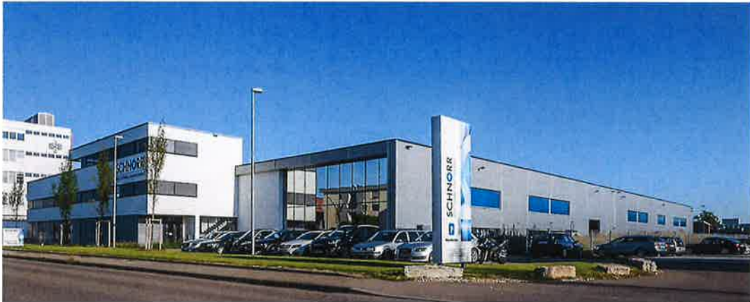
Unser Stammsitz in 71069 Sindelfingen, Stuttgarter Straße 37.
