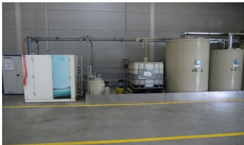
Vakuumverdampferanlage zur Aufarbeitung von Spülwässern
