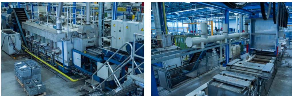
Produktionshalle Sindelfingen mit Durchlaufhärteanlage und Phosphatier-/Brünieranlage
