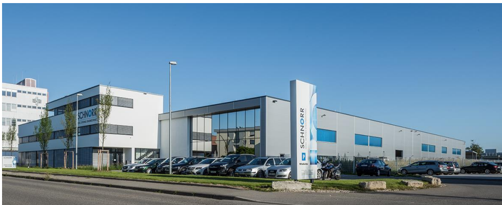
Neue Produktionshalle und Verwaltungsneubau mit Kantinenbereich (links im Hintergrund noch das markante Schnorr-Hochhaus)
