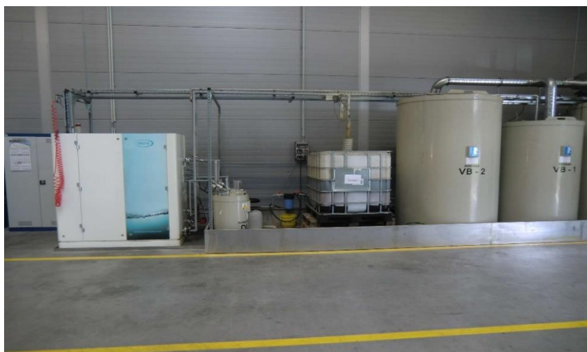
Vakuumverdampferanlage zur Aufarbeitung von Spülwässern
