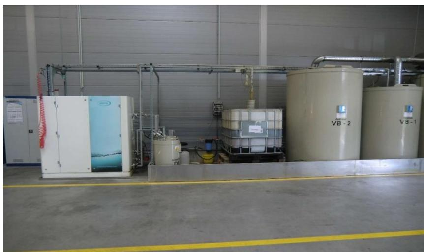
*Vakuumverdampferanlage zur Aufarbeitung von Spülwässern*
