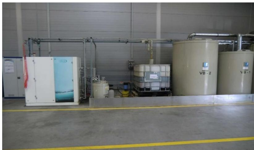
Vakuumverdampferanlage zur Aufarbeitung von Spülwässern
